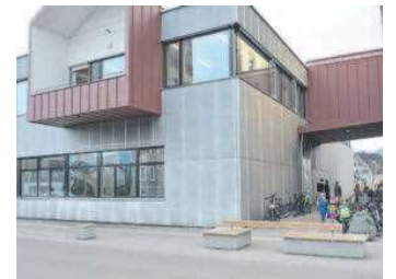
Der Neubau wurde mit dem alten Schulgebäude verbunden.
