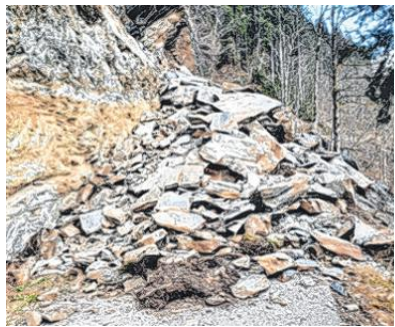
Schutt blockiert die Straße. Foto: APA
