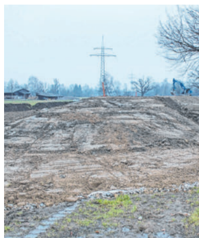
Beim Kreisverkehr in Lauterach wird am Güterbahnhof eine neue Zufahrt erstellt.
