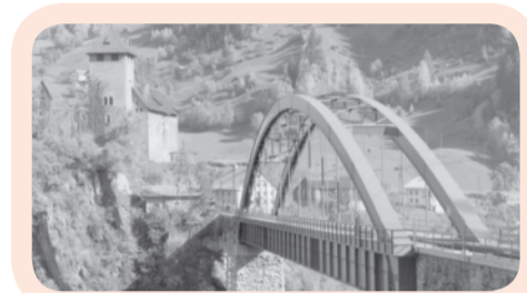
1964 wurde die alte Brücke komplett durch eine neue Stahlkonstruktion ersetzt, indem diese auf einem Lehrgerüst errichtet und im Verlauf einer Nacht in die Widerlager geschoben wurde. Zur damaligen Zeit stellte dieses Verfahren eine ingenieurmäßige Herausforderung dar und wurde weltweit rezipiert.
