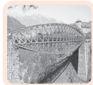
Steigende Achslasten und die Elektrifizierung führten 1923 dazu, dass die Brücke mit einem unten angeordneten Fischbauchträger verstärkt werden musste.
