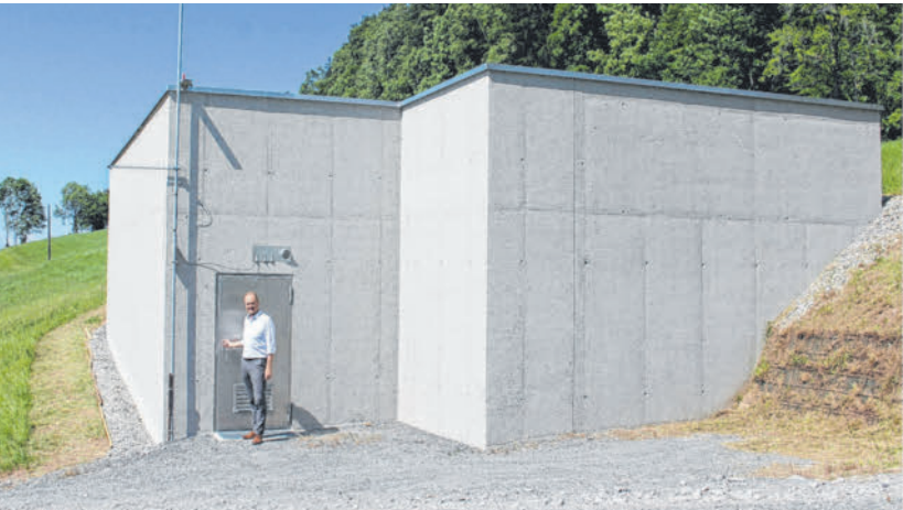
Zweimal 200 Kubikmeter Trinkwasser fasst der neue Hochbehälter in Doren. Er kann zudem Wasser mit Sulzberg und Thal „tauschen“.
