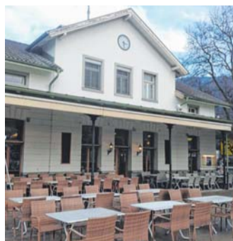
Im Hafenrestaurant wurde zwei Monate lang umgebaut.
