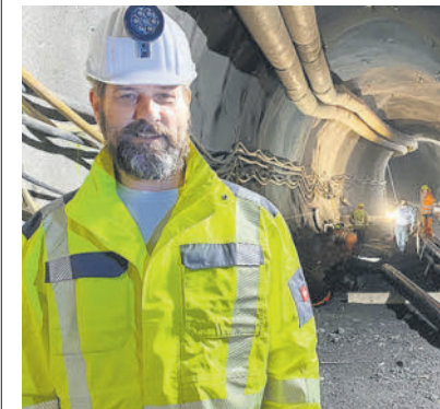
Bernhard Braza: Bis Anfang Dezember erfolgt die Einrichtung der Baustelle.
