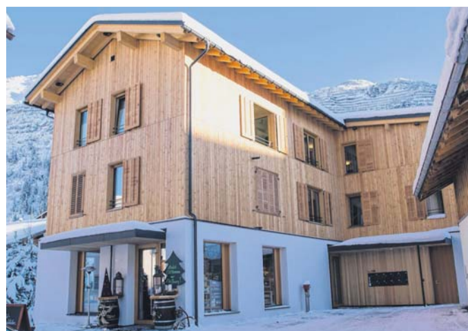
Die Räumlichkeiten für betreubares Wohnen sowie die Geschäftsfäche im Erdgeschoß wurden kürzlich an die Nutzer übergeben. FOTOS: PRISMA
