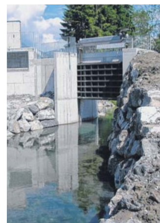
80.000 Euro werden in die Hochwasserschutzanlage investiert.
