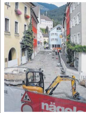
Im „Städtle“ wird bald wieder baggert. FOTO: STADT BLUDENZ
