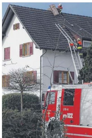
In Göfis trug der Sturm einen Kamin ab. FOTO: MANTL-MUSSACK
