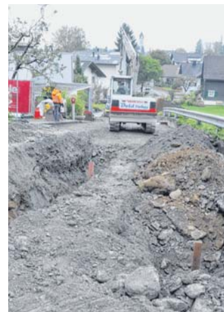
Die erste Etappe der Sanierung nähert sich dem Ende. FOTO: MWE
