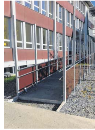
Eine neue Rampe wurde an das Gymnasium angebaut.
