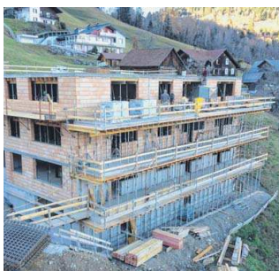
Zwei der drei Wohnhäuser haben bereits Gestalt angenommen. FOTO: WSH
